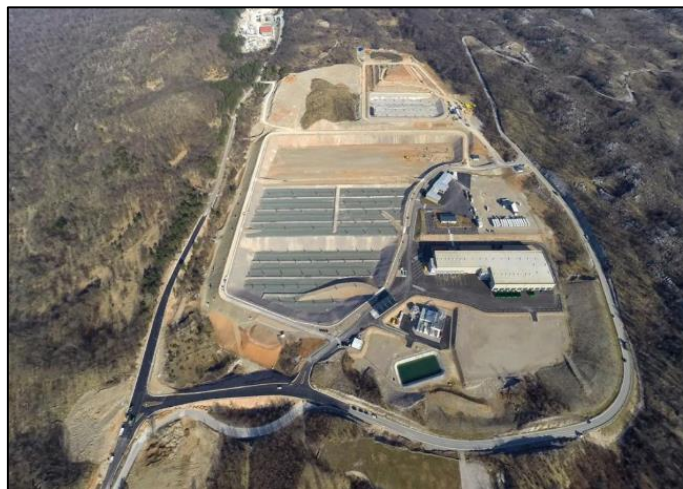
Slika 7. Postrojenje mehaničko biološke obrade u ŽCGO Marišćina (izvor: http://www.ekoplus.hr )
